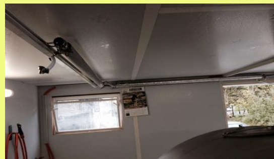
Bild 06: Beispiel einer möglichen Streckenführung. Diese sollte vorher geplant werden und dann an den entsprechenden Stellen die Löcher für die Montageschellen gebohrt werden
