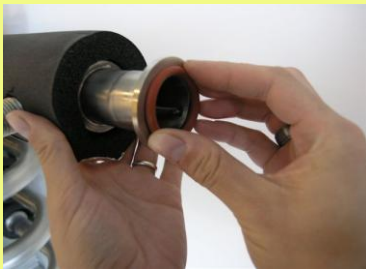
Bild 10: Pro Verbindung eine Dichtung einsetzen. Dichtbereich vorher
