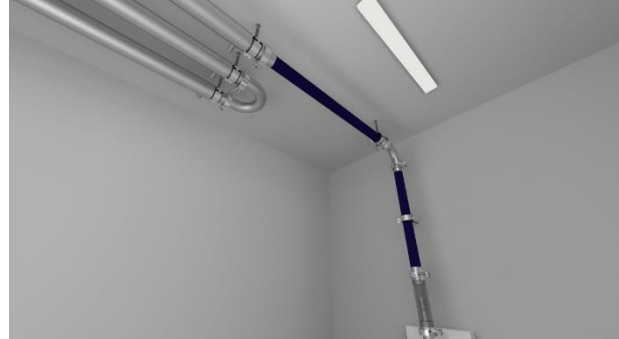
Bild 6: Beispiel einer möglichen Streckenführung. Diese sollte vorher geplant werden und dann an den entsprechenden Stellen die Löcher für die Montageschellen gebohrt werden
