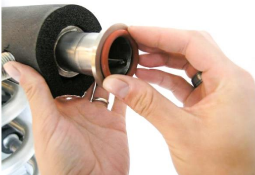
Bild 9: Anlegen der Dichtung
